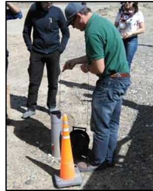
Figura 16. Medición de nivel de agua en pozos geotécnicos existentes
