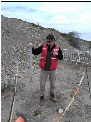
Figura 23. Muestreo de agua en pozos geotécnicos existentes en JC
