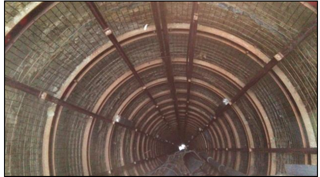
Figura 10. Ingreso a interior del pique en JC
